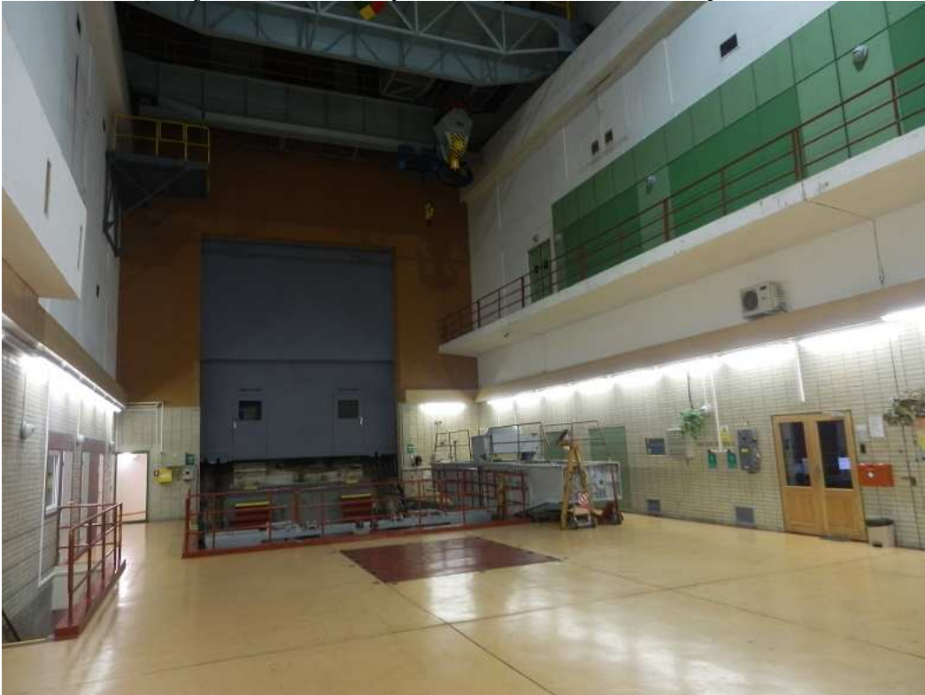
Ve strojovně (kaverně) - pohled na vrata nákladního výtahu
