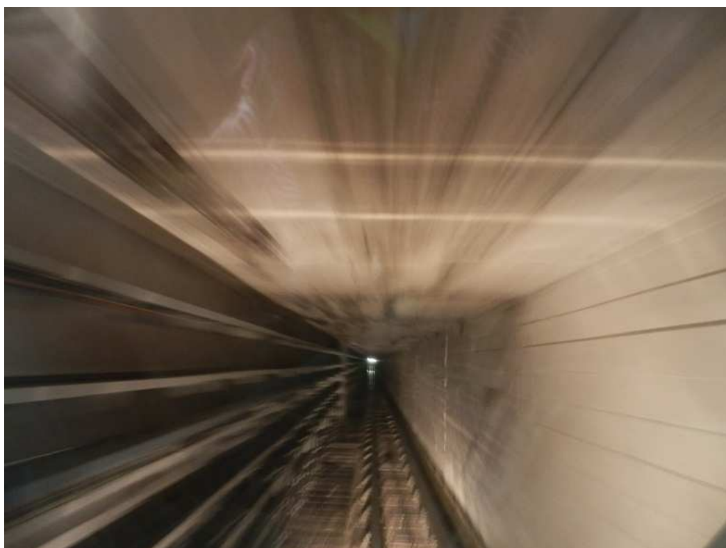
V tunelu – z výtahu
